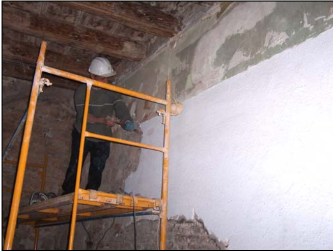
Vista dels treballs de repicat de l'arc UE 107.
