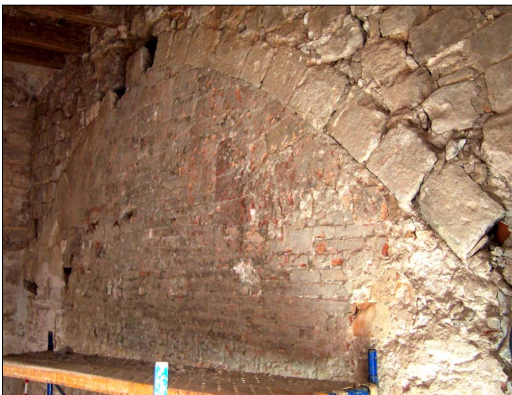
Vista general de l'arc UE 107 un cop finalitzat el repicat.
